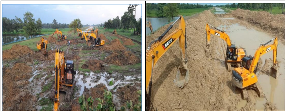
छायाचित्र-3.1: हाइड्रोलिक एक्सकेवेटर (पोकलेन मशीन) का उपयोग कर लक्ष्मीनगर, बलरामपुर में राप्ती मुख्य नहर की खुदायी।
