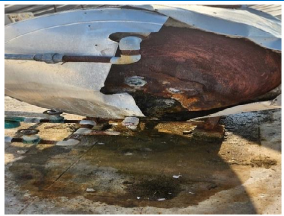
चित्र 11.21 क्षतिग्रस्त सौर जल हीटर (तिरुपति परिसर)
