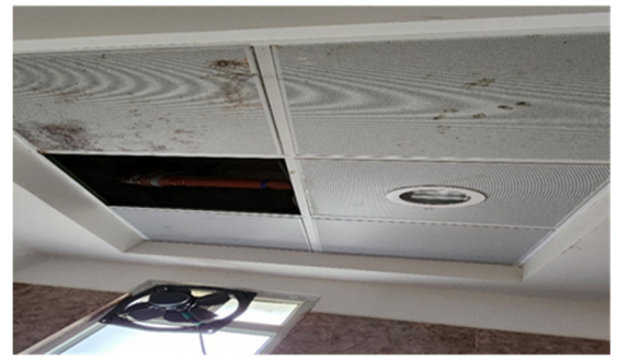
चित्र 11.11 शौचालय की फॉल्स सीलिंग में टाइल लुप्त (तिरुपति परिसर)
