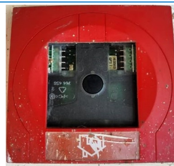
चित्र 11.23 आपातकालीन अग्नि अलार्म बटन क्षतिग्रस्त
