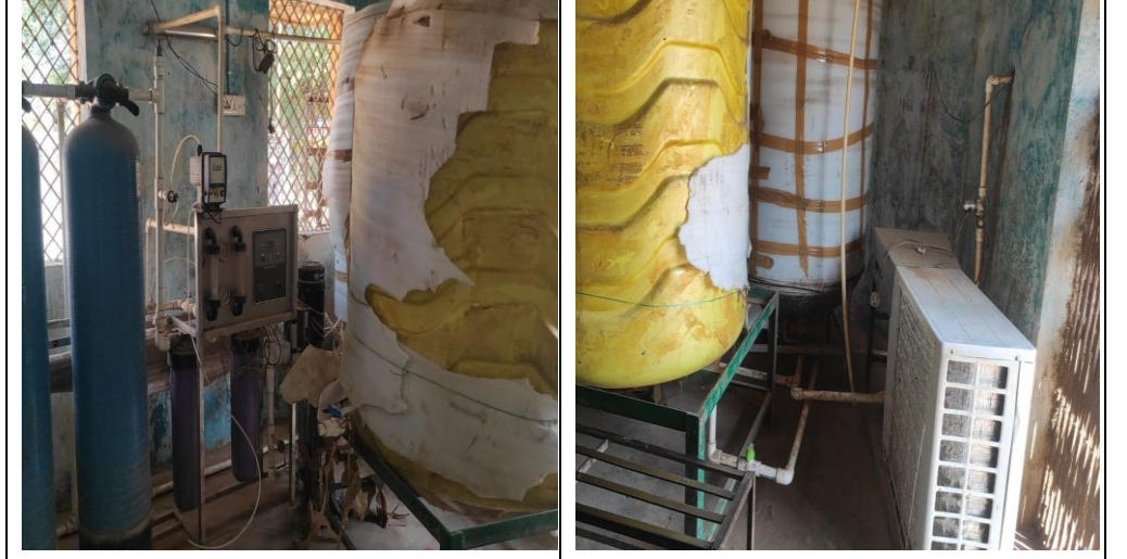
चित्र क्रमांक 5.1: खराब झालेले आरओ वॉटर फिल्ट्रेशन युनिट, दिनांक: 21.02.2024
