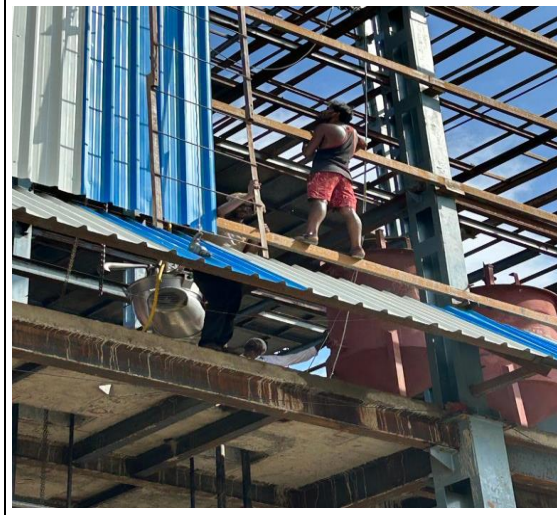
(5 एवं 6) गुप्ता सॉल्वेंट प्राइवेट लिमिटेड, मुरैना में बिना सुरक्षा जाल के, हेलमेट एवं सेफ्टी बेल्ट पहने ऊंचे भवन का निर्माण कार्य करते हुए कर्मकार
