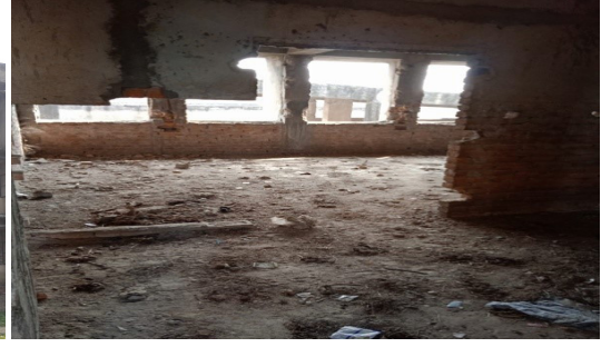
चित्र 2 : क्षतिग्रस्त दीवारे एवं खिड़कियाँ (रखरखाव के अभाव के कारण)
