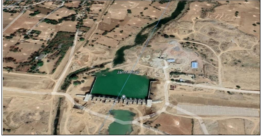
चित्र 3.1: जनपद ललितपुर में भौराट बांध का निर्माण (दिनांक 6 अप्रैल 2021)
