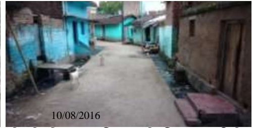
रेलवे स्टेशन, साहिबगंज के निकट नाली में जमा सिल्ट
