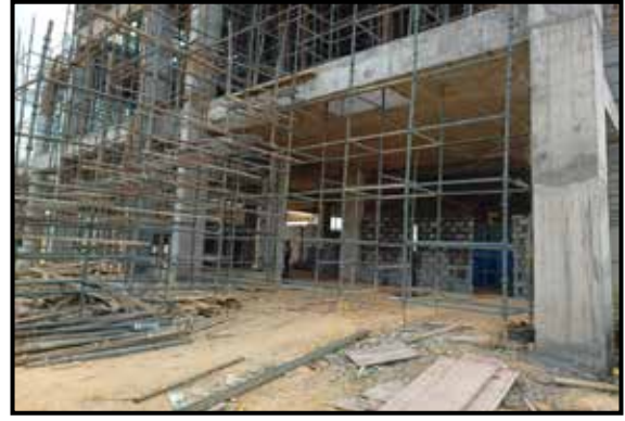
चित्र 8ख - कोथनूर डिपो में सांचा प्रणाली का अनुचित आधार एवं खराब कंक्रीटिंग
