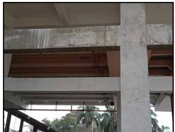
चित्र 10ख - सेंट्रल सिल्क बोर्ड स्टेशन के निर्माण में बीमों में मधुकोशनुमा संरचना
