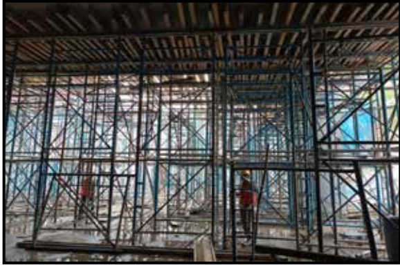
चित्र 8क - कैंटोनमेंट स्टेशन पर उत्तम सांचा प्रणाली
