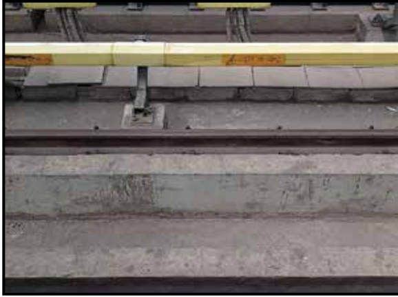
चित्र 9ग - नागासंद्रा स्टेशन पर रेल की पटरियों के नीचे प्लिंथ की बीम पर दरारें
