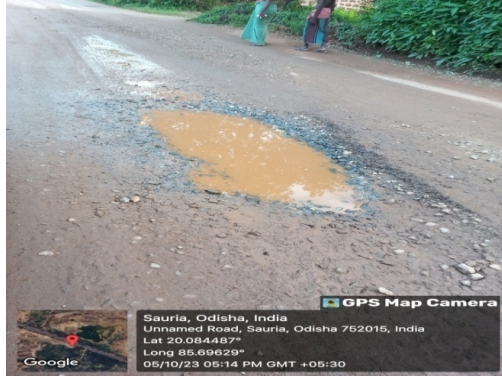
ଫଟୋ ସଂଖ୍ୟା-6: ପଢାନୟିକିଆ-ଡେଲାଇ-ଖୋର୍ଦ୍ଧା ସଡ଼କର ବଡ଼ ବଡ଼ ଗର୍ଭ ସହିତ କାର୍ଯ୍ୟାନୁଷ୍ଠାନ ହୋଇନଥିବା ଅଂଶ (ଖୋର୍ଦ୍ଧା ଆରାଧିବି)
