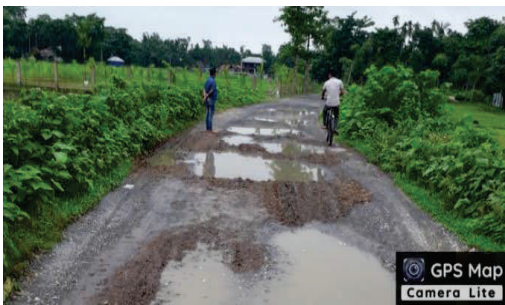
চিত্র 4.15: বড় আকারের গর্তগুলি বৃষ্টির জলে পরিপূর্ণ
