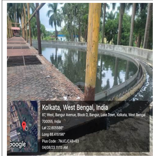
চিত্র 4.16: এস টি পি-তে প্রাথমিক পরিশোধন পাত্র
