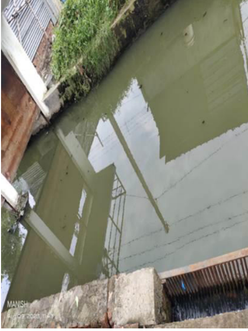
চিত্র 4.1: কাছের একটি নিকাশি নালা থেকে নর্দমার একটি অংশ পাম্পিং স্টেশনে নিয়ে যাওয়া হচ্ছে এস টি পি-তে ভরার জন্য
