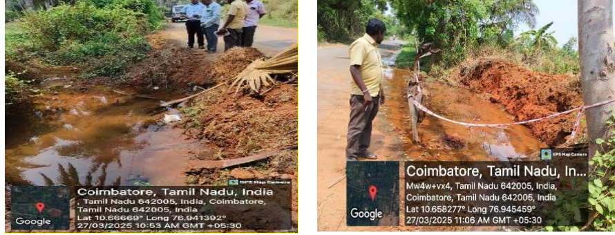
விளக்கப்படம் 2.3: குழாய்களில் ஏற்பட்ட கசிவுகளால் உண்டான நீர் தேக்கம்
