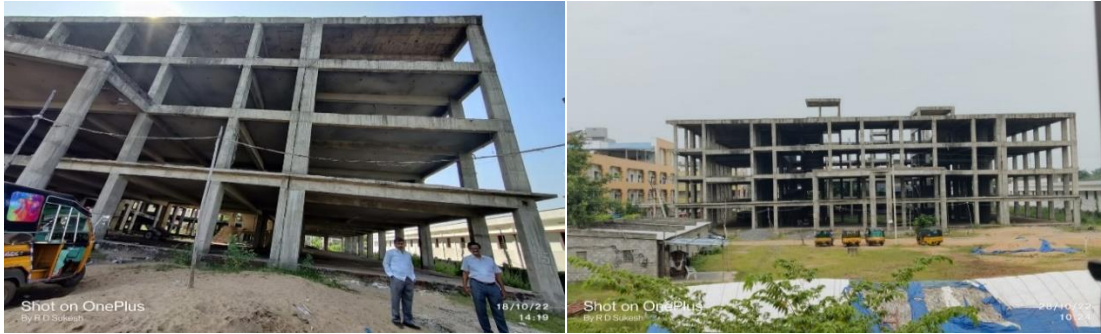
ఫాయా చిత్రం 10.5: గుడివాడలో హోమియో వైద్య కళాశాలకు అనుబంధంగా ఉన్న ఆసుపత్రిలో అసంపూర్తిగా ఉన్న నూతన భవన నిర్మాణము (2022 అక్టోబర్)
