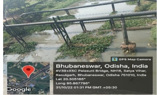
ଫଟୋ 5: ଭୁବନେଶ୍ୱର ପଳାସୁଣୀ ସେତୁ ନିକଟ ଗଙ୍ଗୁଆ ନାଳରେ ପୁରୁଣା କ୍ଷତିଗ୍ରସ୍ତ ଜଳ ଯୋଗାଣ ପାଇପ୍ ଲାଇନ୍
