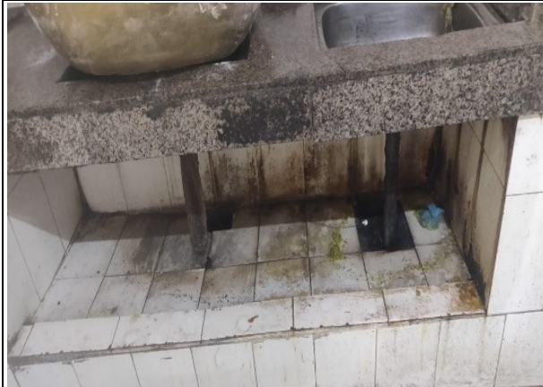
चित्र 3.23: आईजीएमसी शिमला में रसोई सिंक टूटा हुआ व अवरुद्ध स्थिति में पाया गया
