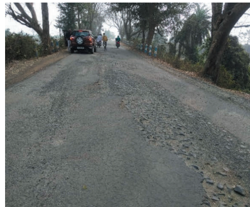
চিত্র 2.4: সিমলিপাল-সারেঙ্গা-বামুন্ডিয়াঘাট রাস্তার 9.5 কিমি-তে ডব্লিউ এম এম উন্মুক্ত হয়ে আছে (16.01.2021)
