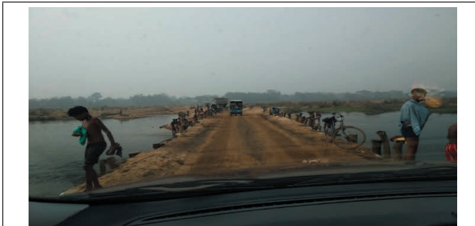
চিত্র 2.12: বাঁকুড়া রাজপথ বিভাগের চন্দ্রকোনা-গোয়ালতোড়-সিমলিঘাট রাস্তা। একটি অস্থায়ী সেতু যেটি বর্ষাকালে অব্যবহারযোগ্য হয়ে পড়ে
