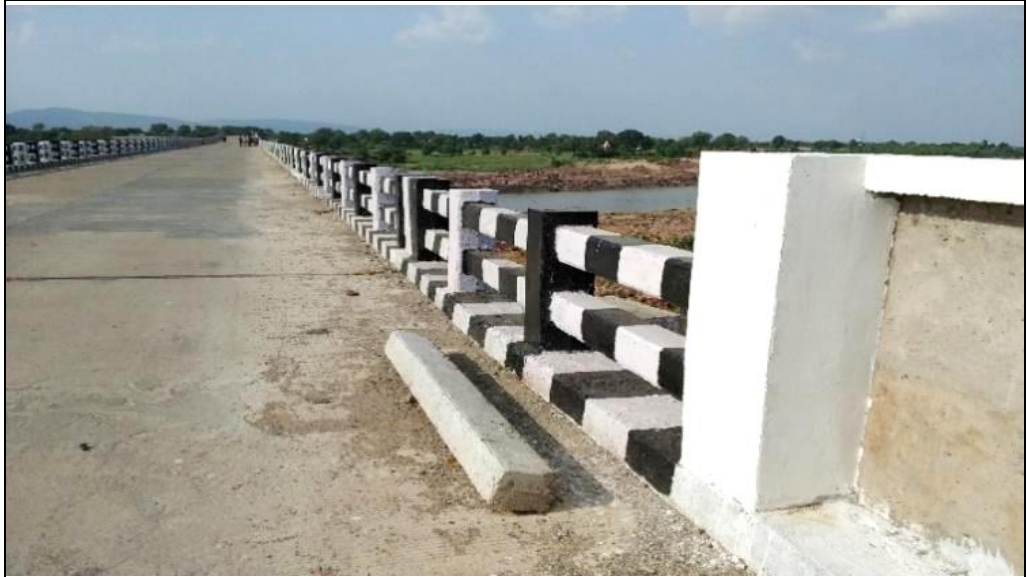
अवलीघाट से सलकनपुर रोड, सीहोर में बिना फुटपाथ का हाई लेवल पुल (स्रोत: लेखापरीक्षा दल द्वारा 06.07.2021 को ली गई तस्वीर)
