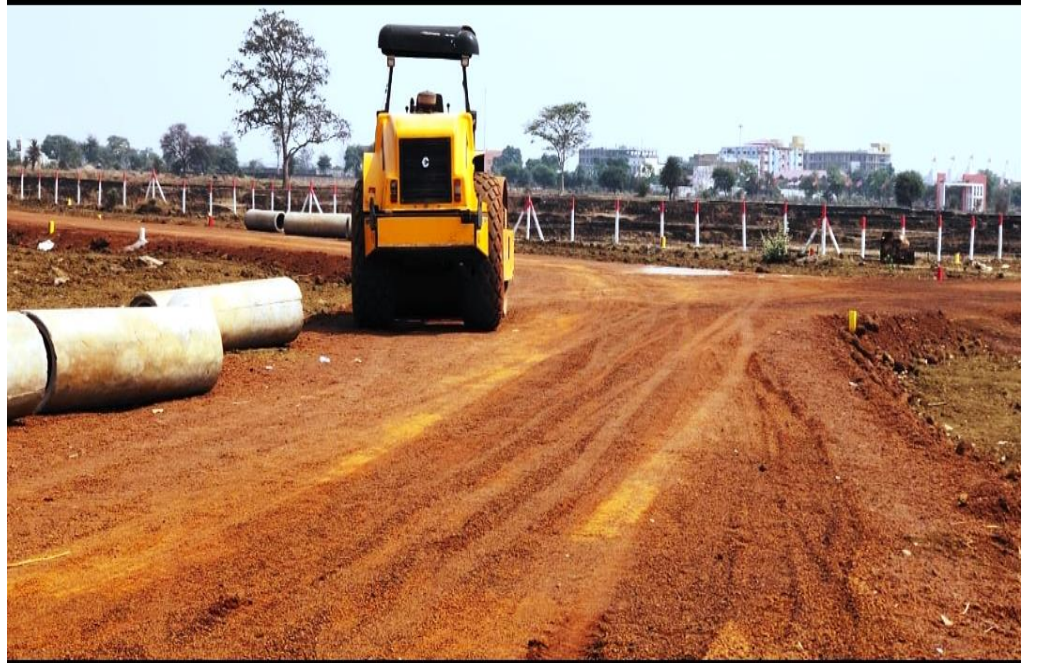
चित्र-2.2 (क): निजी निर्माण स्थलों पर मुरुम के उपयोग को दर्शाने वाला चित्र (आवासीय परियोजना, रायपुर, चित्र का माह: सितंबर 2021)
