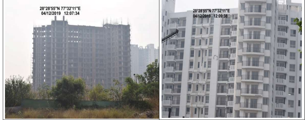
छायाचित्र 5.2.1: पार्श्वनाथ डेवलपर्स प्राइवेट लिमिटेड को आवंटित भूखण्ड संख्या जीएच 11, सेक्टर पी आई के निर्माण की स्थिति
