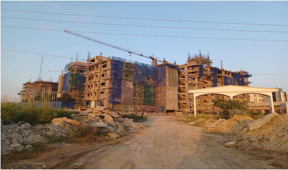
पी.जे.एम.सी.एच, दुमका का अपूर्ण अस्पताल भवन (22.08.2022)
