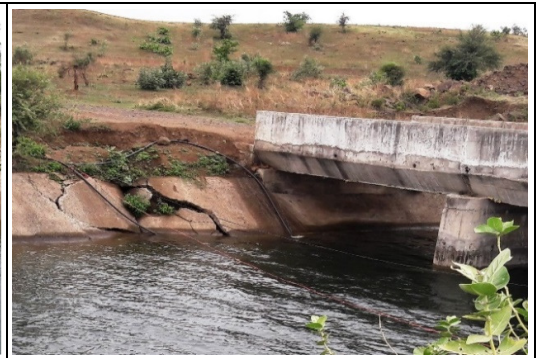
आर.बी.सी. मुख्य नहर (चरण-I) की क्षतिग्रस्त सी.सी. लाइनिंग का दृश्य (जुलाई 2017 की स्थिति में)
