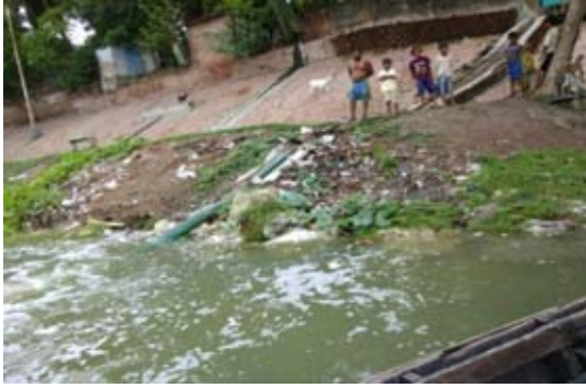
प्लेट 4.1: स्टीमर घाट आउटफॉल (जियागंज-अजीमगंज)
