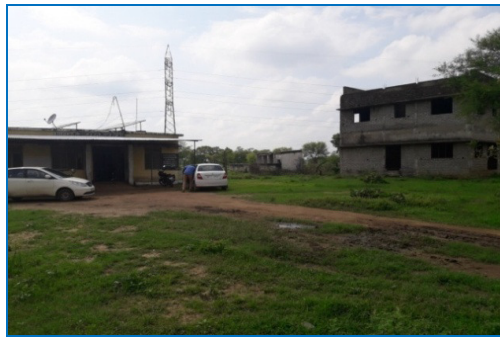
पीएचसी बोदसारा के आस-पास में निर्माणाधीन एसएचसी, बोदसारा छत्तीसगढ़ में अपूर्ण पड़ा रहा
