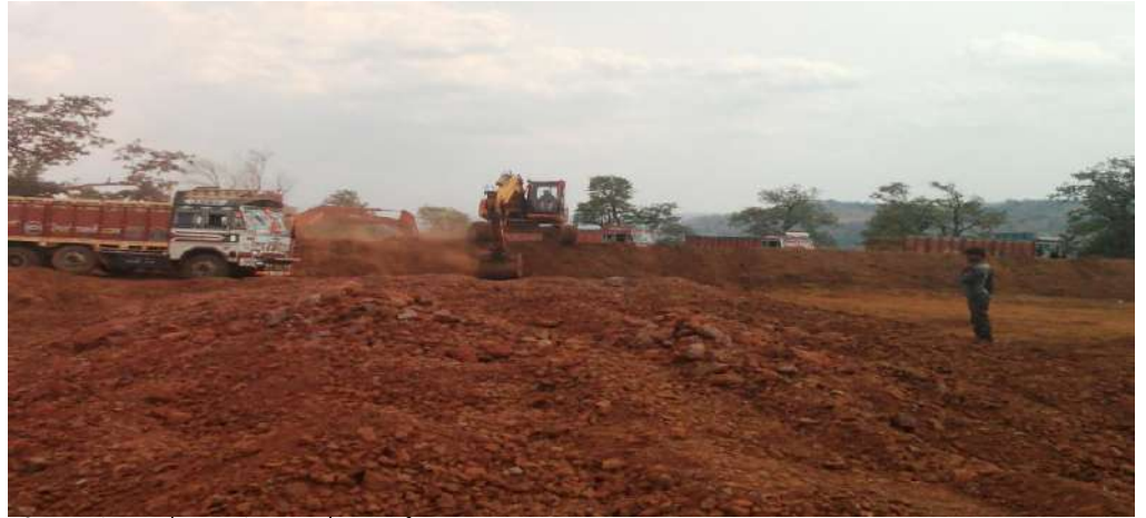
(जिला कबीरधाम के दलदली खदान में बॉक्साइट खनन)
