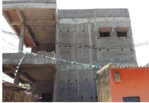
(रायगढ़ शहर का अपूर्ण जोन कार्यालय भवन)
