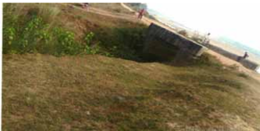
गया जिले के मोहनपुर प्रखंड के मोहाने नदी पाईन में पानी का बहाव नहीं हो रहा है
