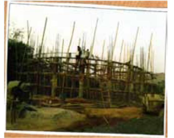
भागलपुर जिला के कहलगाँव एवं पीरपैती प्रखण्ड के बहु-ग्रामीण पाईप जलापूर्ति योजना में निर्माणाधीन मास्टर एलिवेटेड सेवा जलाशय
