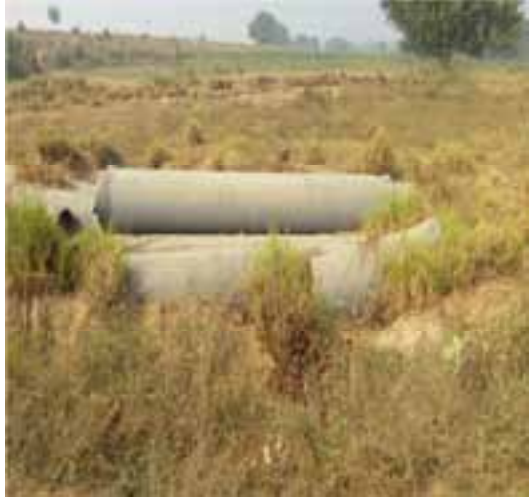
बक्सर जिला के सिमरी प्रखंड से संबंधित पाईप खेत में बिखरे हुए।
