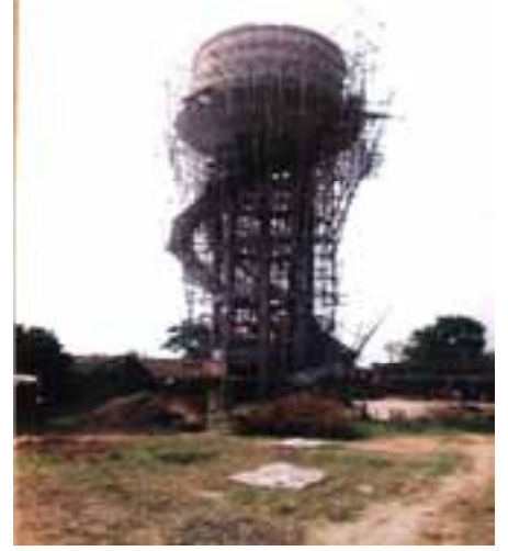
भागलपुर जिला के सुल्तानगंज एवं नाथनगर प्रखंड के बहु-ग्रामीण पाईप.जला.यो. के निर्माणधीन एलिवेटेड सेवा जलाशय
