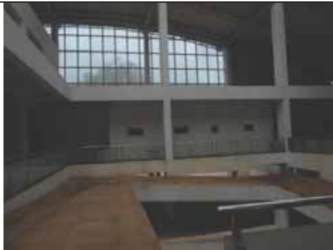
दपरे में हुबली के स्टेशन भवन को रैंप से जोड़ने का अपूर्ण कार्य
