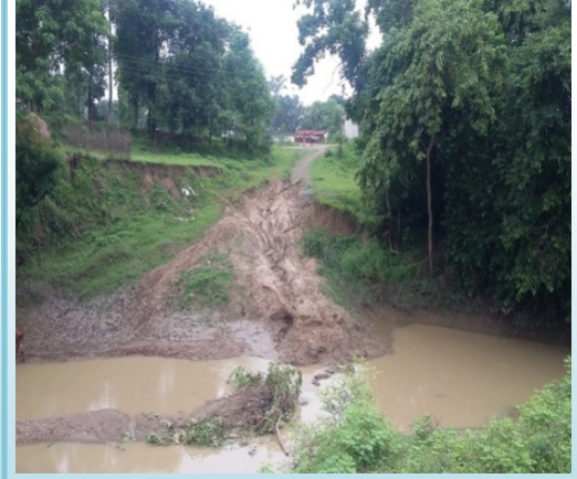
जलनिकासी मार्ग निर्माणकार्य का निष्पादन नहीं किया गया (बिलासपुर जिला - छत्तीसगढ़ टी 02 कुली कुकड़ा-बासाह सड़क निर्माण कार्य (पैकेज सी.जी. 0268)
