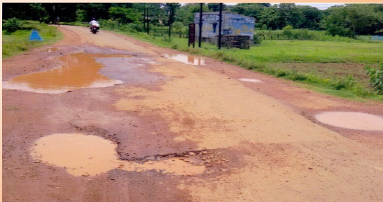
ओडिशा के धनकनाल जिला में सड़क का अनुरक्षण न होने के कारण मराठापुर-जमुनाकोटी सड़क पर गड्डे हो गए हैं।
