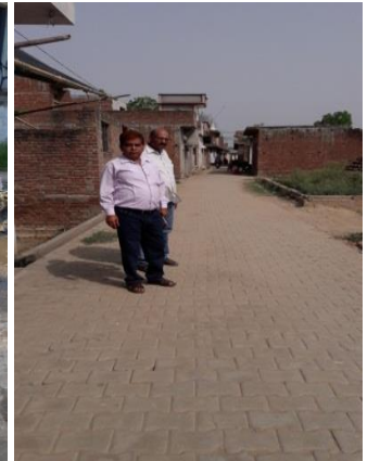
जनपद-सम्भल के क्षेत्र पंचायत बनियाखेड़ा द्वारा कराया गया कार्य अच्छी गुणवत्ता की इण्टरलाकिंग का सड़क निर्माण कार्य
