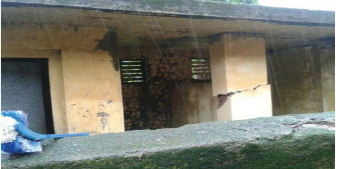
चित्र-6: उच्च प्राथमिकता विद्यालय, वरोली तलत, वलसाड़ जिले, गुजरात के क्षतिग्रस्त स्थिति में शौचालय ब्लॉक
