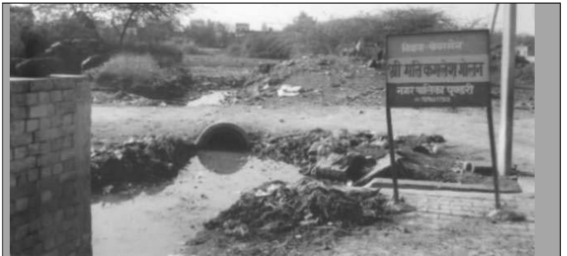
कच्ची अपवाहिका में छोड़ा गया अपशिष्ट जल, पुण्डरी के खुले क्षेत्र में बहता हुआ (10 अप्रैल 2012)
