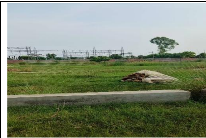
फोटोग्राफ संख्या 2.3: ग्राम पंचायत बियाना में पार्क के निर्माण का कार्य
