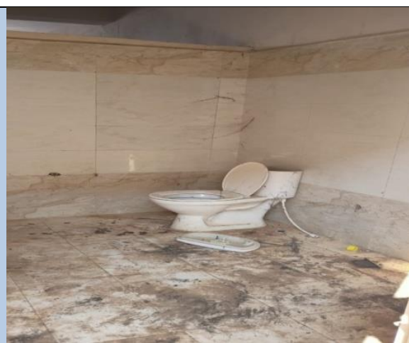
चित्र 4.15: मेदारम, जनजातीय परिपथ, तेलंगाना में एम्फीथिएटर में उपलब्ध कराए गए शौचालयों में टूटी हुई सेनेटरी फिटिंग
