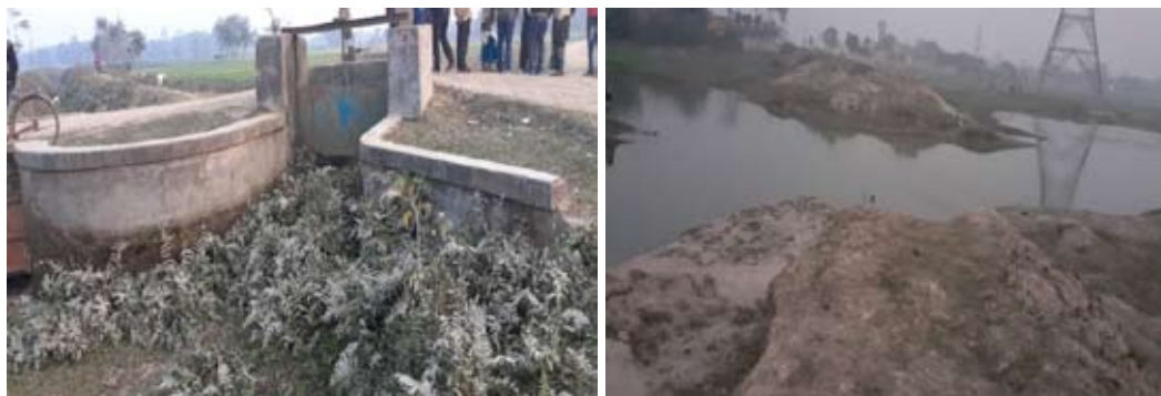
पूर्वी कोसी नहर प्रणाली के अंतर्गत सिबरबन्नी वितरणी पूर्वी कोसी नहर प्रणाली के अंतर्गत सपा वितरणी के आर.डी. 26.63 पर अक्रियाशील क्रॉस रेगुलेटर 28 में दरार
